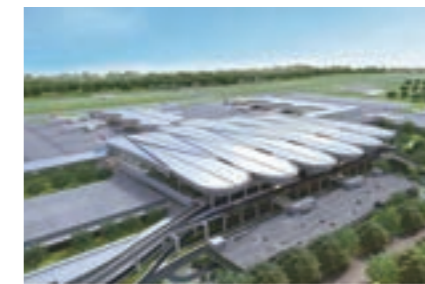
バンドラナイケ国際空港改善事業 フェーズ2(パッケージA)(施工中工事)(スリランカ民主主義共和国) 発注者:スリランカ空港公社
