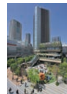
小杉町3丁目東地区(神奈川県川崎市) 発注者:小杉町3丁目東地区市街地再開発組合
