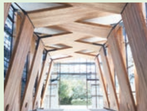
② CLT活用技術：風洞実験棟・内観(装置設置前)
