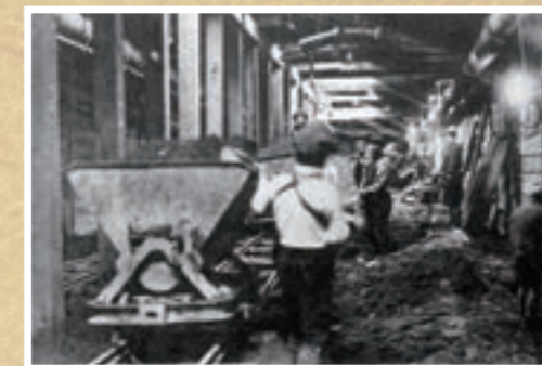
1927年(昭和2年) 東京地下鉄道(上野～浅草間) 地面を掘り下げてトンネルをつくり、完成後に埋めもどす開削工法を採用
