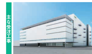
(仮称) 沢井製薬 第二九州工場 新棟建設工事 (福岡県飯塚市) 発注者: 沢井製薬(株)
