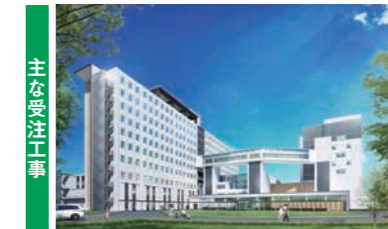
武蔵野赤十字病院施設整備事業 (増改築・改修・解体等工事) (東京都武蔵野市) 発注者: 日本赤十字社
