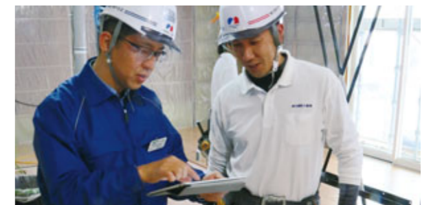
施工現場でタブレット端末を活用している様子
