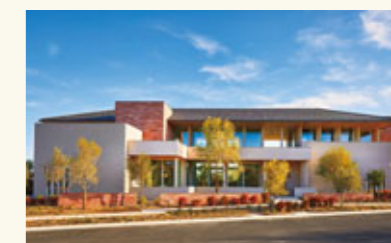
現地で建設した「シャーウッド」
