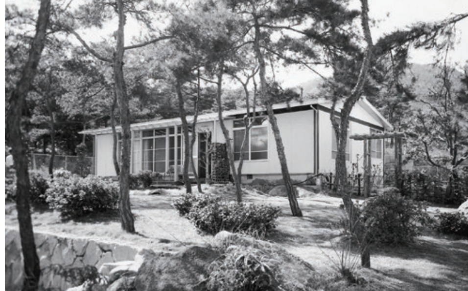
1961年に主力商品の原点「B型」を発売。 屋根を切妻とし、外壁には工場生産の高性能アルミサンドイッチパネル「Aパネル」を使用
