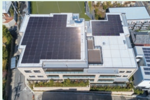
日本初の全住戸ZEHの分譲マンション(愛知県名古屋市)
