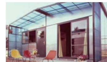
木造住宅が常識だった時代に、鉄・アルミ・プラスチックを建材として建てられた「セキスイハウスA型」は当時の最先端の住宅となった
