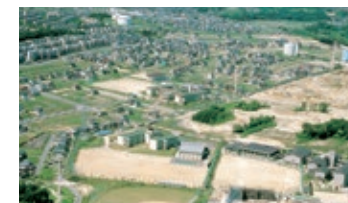
「総合住宅研究所」（京都府木津川市）の完成は、積水ハウスの本格的な研究・開発の拠点となり、住宅業界に大きなインパクトを与えた
