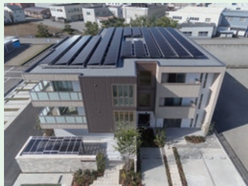
日本初の全住戸ZEHの賃貸住宅(石川県金沢市)
