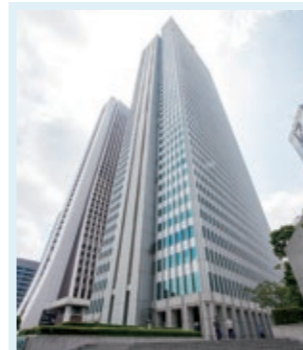
1978年竣工 新宿野村ビル 延床面積:58,512㎡*
