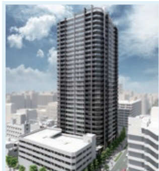
錦二丁目7番地区市街地再開発 (愛知県 名古屋市 中区) 竣工予定:22年3月期 主用途:住宅、商業施設、駐車場
