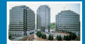
1990年～竣工 民間単独では最大級の業務系開発「横浜ビジネスパーク(YBP)」竣工
