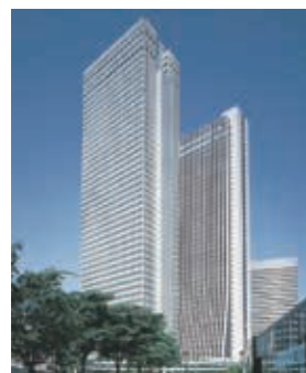
新宿野村ビル 1978年竣工 延床面積:58,512㎡ ※1
