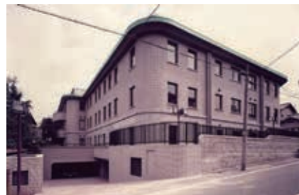
1984年：竣工当時の写真
