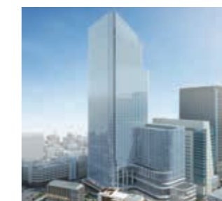
日本橋一丁目中地区再開発 ※1 竣工予定:2026年3月期 主用途:オフィス、商業施設、ホテル、サービスアパートメント、住宅、カンファレンス 延床面積:約373,200㎡
