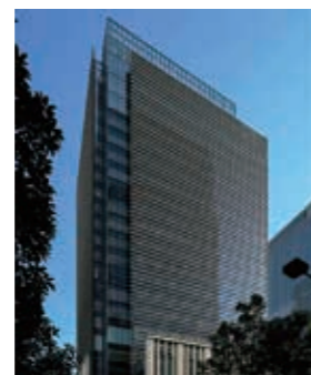
日本橋室町野村ビル 2010年竣工 延床面積:44,989㎡
