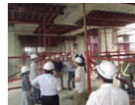
現場巡回を通じた、施工不良の回避
