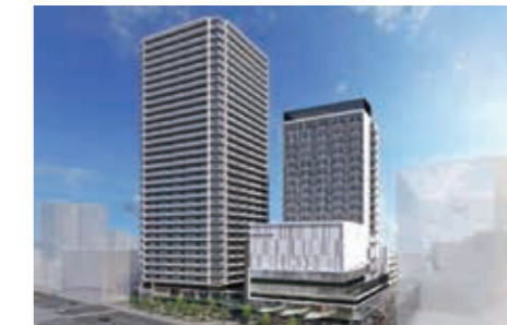
岡山市駅前町一丁目2番3番4番地区再開発 ※1 竣工予定:2026年3月期(住宅棟)/2027年3月期(街区全体) 主用途:住宅(約400戸)、ホテル、商業施設、駐車場
