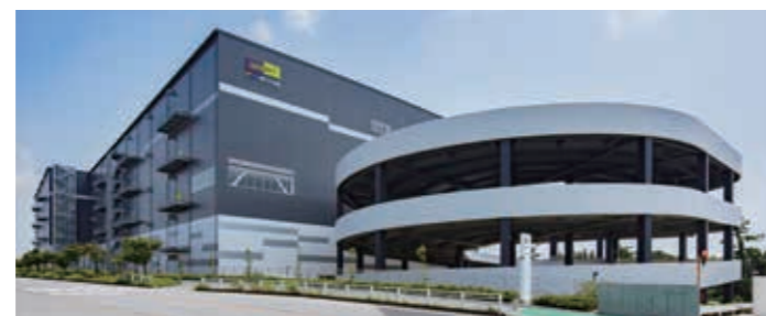
Landport東習志野 2019年竣工 延床面積:61,573㎡ ※2
