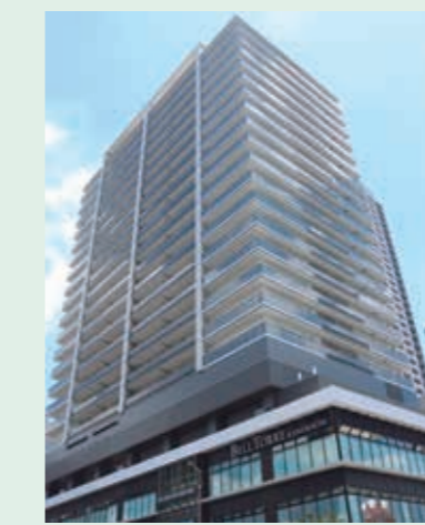
ベルトーレ金町 (住宅部分の名称: プラウドタワー金町) 所在: 東京都葛飾区 竣工: 2021年7月 総戸数: 住宅(190戸)、商業施設、業務施設
