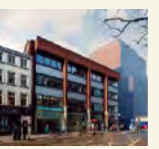
(現在)建物外観
