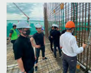
建設現場での施工チェック(ベトナム)
