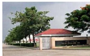
Teijin Corporation(Thailand)の工場
