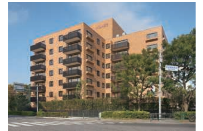
王子ホームズ青山外観(所在地:東京都港区南青山)
