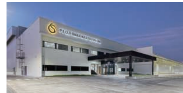
インドネシア 段ボール新工場
