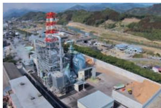
バイオマス発電所(王子グリーンエナジー日南/宮崎県)
