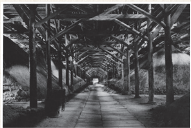
過磷酸石灰90間倉庫
