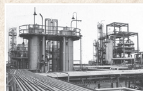
エチレン工場
