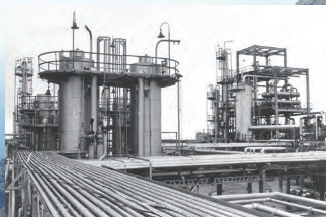
エチレン工場
