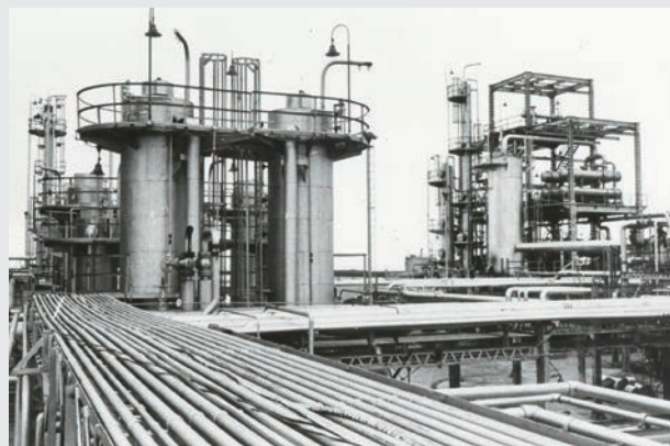
エチレン工場
