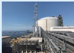
2022年3月、愛媛工場敷地内に国内最大級のLNGタンクが完成し、供給を開始
