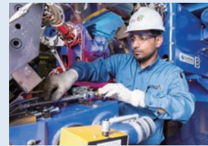
ペトロ・ラービグ社での作業の様子
