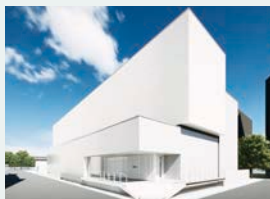
S-RACMO 第2系列(建設中)
