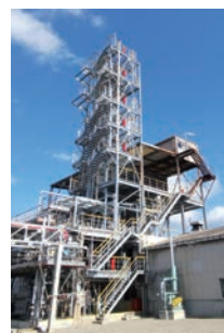
ケミカルリサイクル実証設備
