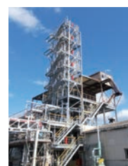
ケミカルリサイクル実証設備
