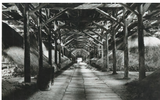
過燐酸石灰 90間倉庫
