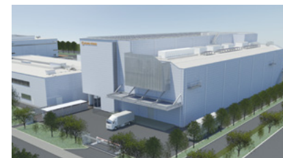
新バイオ医薬原薬製造棟「HB7」(2025年3月完成予定)
