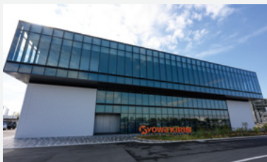
ZEB認証を取得した新事務所棟(宇部工場)
