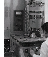
電子顕微鏡による ハロゲン化銀解析(研究所)
