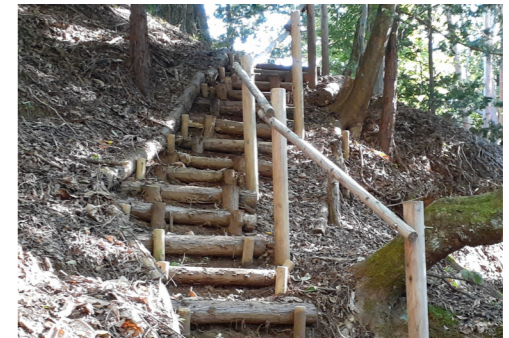
完成した遊歩道
