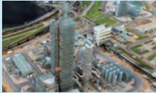
米国・CO 2 回収プラント
