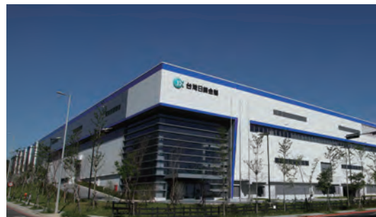
スパッタリングターゲット主要生産拠点 龍潭工場 (台湾)
