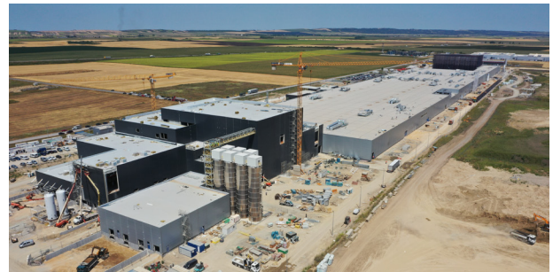
建設終盤を迎えたセルビア工場全景
