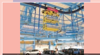
自動車整備工場のパーツ搬送設備 オートラン パンガード
