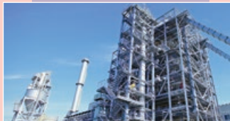
バイオマス発電所 バケットエレベータ・フローコンベヤ
