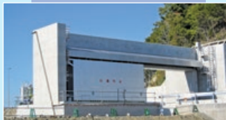
防潮水門 ケーブルベヤ
