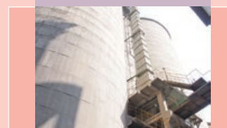
セメント工場 バケットエレベータ
