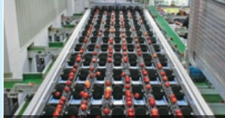
リンゴ加工工場の選別マシン 小形コンベヤチェーン
