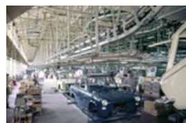
自動車工場納入の天井走行コンベヤ・ノーマンカーブ（1961年）
