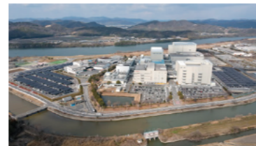
左側がNo1ソーラーパワープラント、 右側がNo2ソーラーパワープラント
