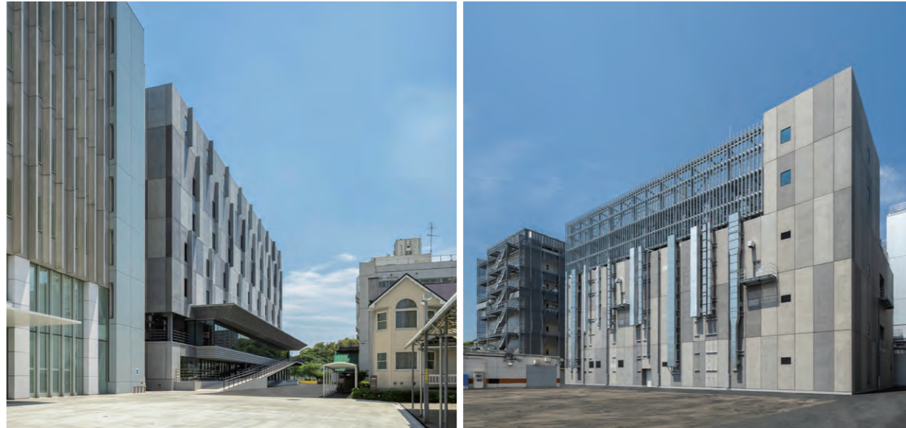
研究開発拠点 藤沢テクノセンターに新たに建設された実験棟(2022年5月竣工) 第103建物(左)は、最新の試験環境を整備するとともに、個人からグループレベルで創造力を高めることができる最適な執務環境を提供します。第104建物(右)は、開発・生産用のクリーンルームなど、azbilグループのセンシング技術の要であるMEMS (Micro Electro Mechanical Systems) センサの開発施設および計測標準施設を設置しています。先進的な研究開発環境を構築するため、半導体製造用の高いクリーンレベルや極めて安定した温湿度環境等を実現するエネルギー消費の高い施設、設備を備えています。ビルディングオートメーション事業の技術・ノウハウ、蓄積したデータをもとにした各種の省エネルギー施策を盛り込むことによってエネルギー原単位で比較して、同機能の建物を大きく下回る値(当社比較)を実現しています。
