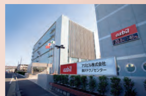
アズビル株式会社 (藤沢テクノセンター)
