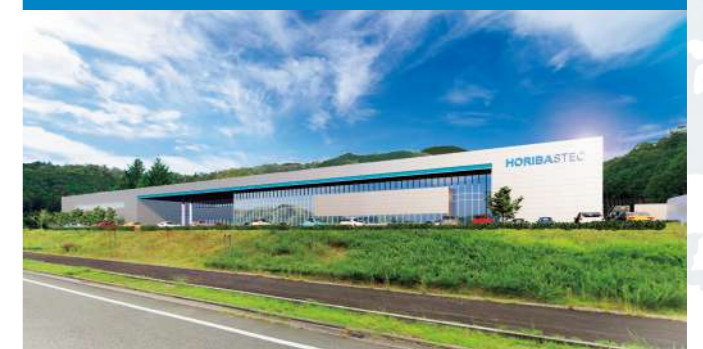
堀場エステック社 京都福知山新工場(仮称)(2026年1月竣工予定)
