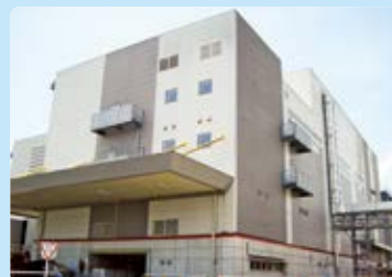
新設備を導入する吾妻工場の既存工棟
