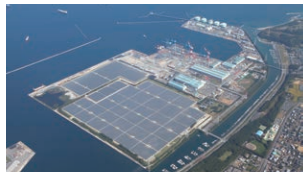
大分日吉原太陽光発電所全景
