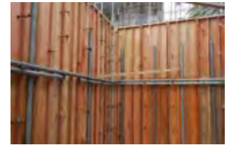
型枠コンクリートパネル
