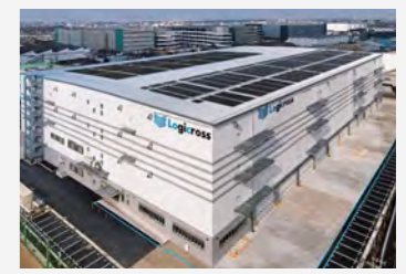
ロジクロス座間小松原
