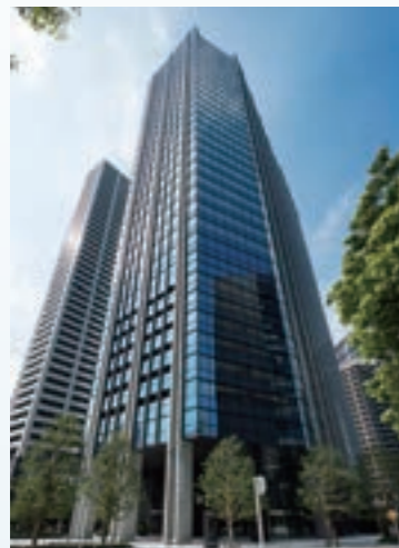
住友不動産新宿セントラルパークタワー 2019年8月竣工
