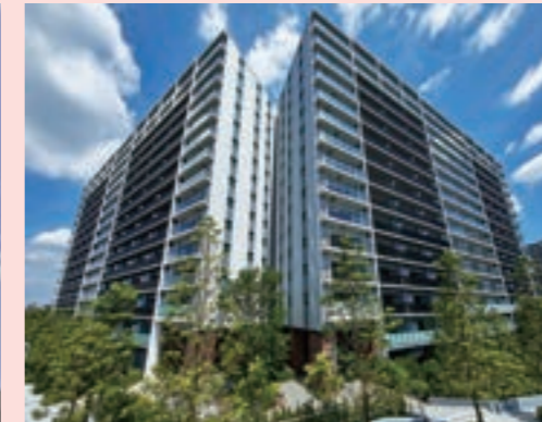
シティテラス金町 (2021年竣工) 東京都葛飾区 販売戸数：610戸 階数：19階
