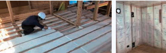
断熱材を床、壁、天井に施工している様子
