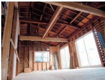
施工中(構造躯体まで解体した状態)
