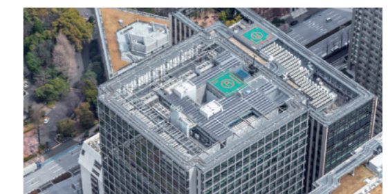
飯野ビルディング屋上の太陽光発電設備
