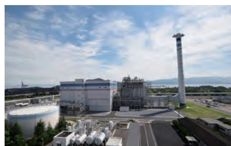
発電効率の高いLNGコンバインドサイクル発電へのリプレース(坂発電所2号機)
