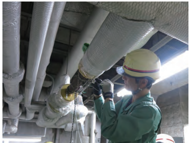
冷水配管のエネルギー使用量の測定結果に基づき、ソリューション提案を実施
