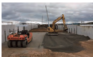
国道へのポーラスサンド軽量盛土施工 (徳島県)
