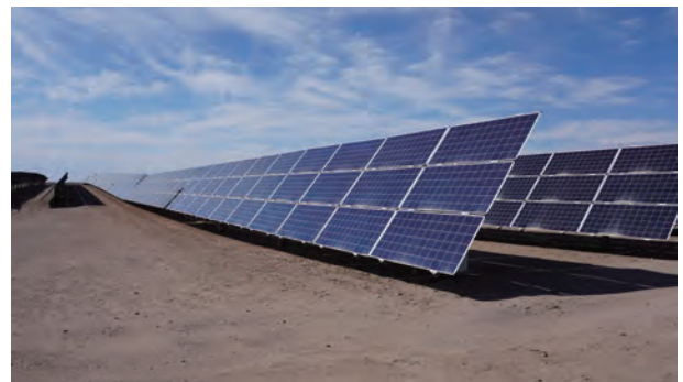
チリでの太陽光パネル設置状況
