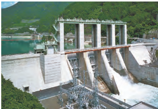
面河第三発電所(愛媛県上浮穴郡久高原町)
