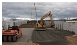
国道へのポーラスサンド軽量盛土施工 (徳島県)
