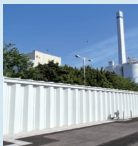
橘湾発電所の沿岸部を囲む防潮堤
