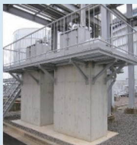
火力発電所のポンプの嵩上げ
